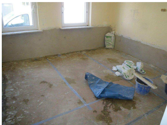
6) Verputzt mit Sanierputz-WTA
