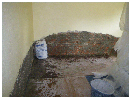
5) Grundierung mit epasit Haftspritzbewurf
