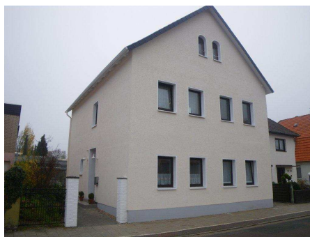
1) Das Haus nach der Sanierung
