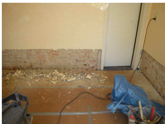
4) Putz und Mörtel im Sockelbereich entfernt
