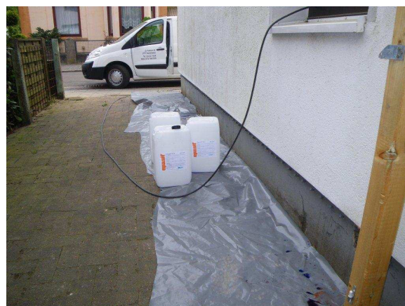
3) Horizontalsperre mit Mauersanit flüssig
