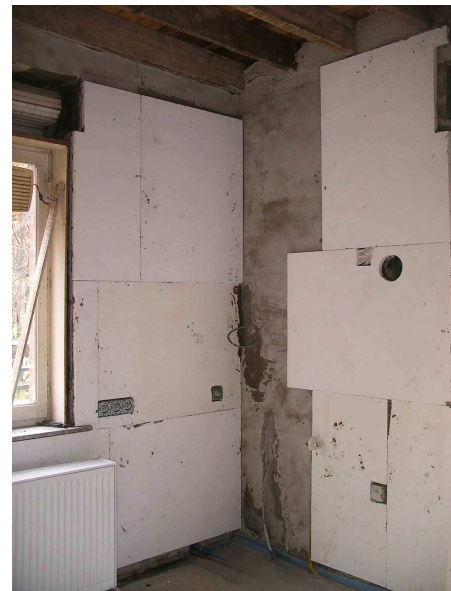
Calciumsilikatplatten werden passgenau verklebt. Bild: epasit
