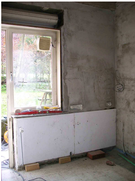
Die Wände werden mit Kalkputz egalisiert. Bild: epasit
