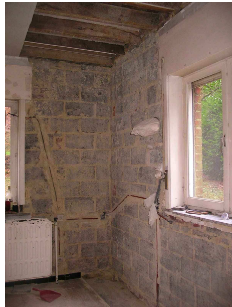
Der schadhafte Putz ist entfernt, Blick auf das Ziegelmauerwerk. Bild: epasit
