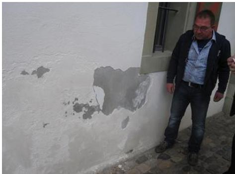
Bild 3: Der ausführende Unternehmer T. Liechti begutachtet die Schäden an der Fassade
