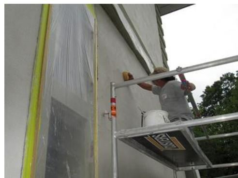
Bild 6: Der Sanierputz wird geglättet
