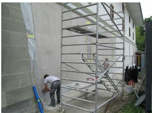
Bild 5: Sanierputz wird aufgezogen
