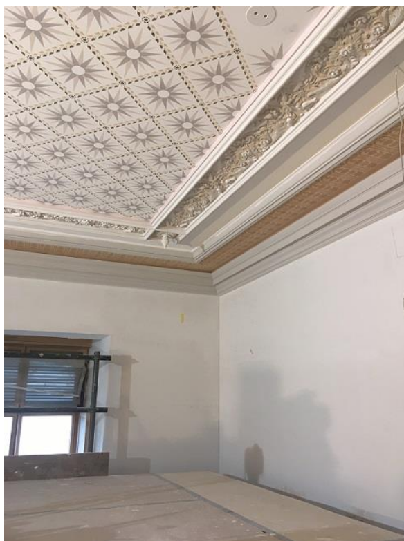
Bild 3 u. 4: Die Innenseiten der Außenwände werden mit epatherm Platten verkleidet.
