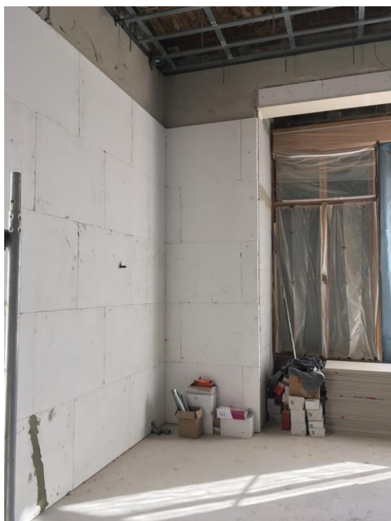
Bild 3 u. 4: Die Innenseiten der Außenwände werden mit epatherm Platten verkleidet.
