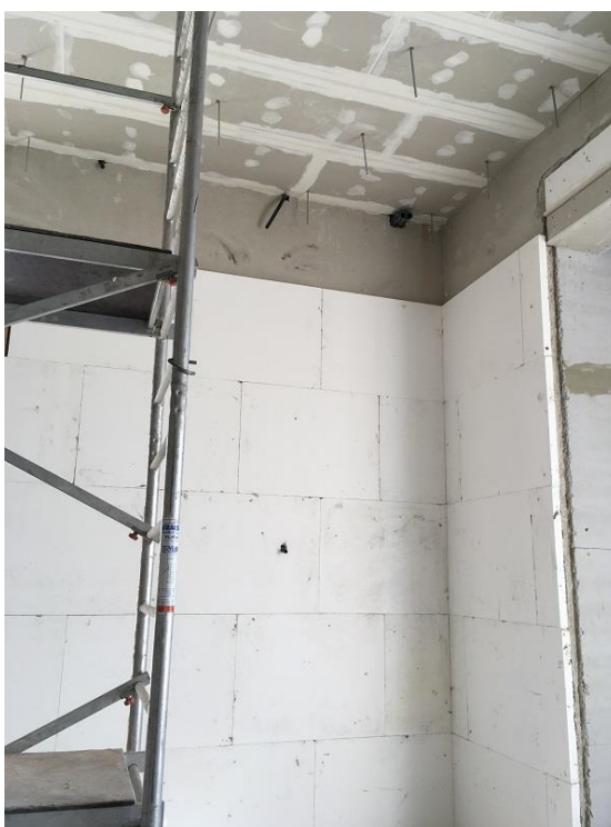
Bild 3 u. 4: Die Innenseiten der Außenwände werden mit epatherm Platten verkleidet.
