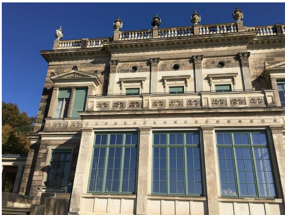
Bild 2: Blick auf das mit epatherm sanierte Obergeschoss
