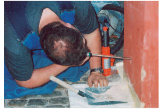
3 Betrachtung des Mauerwerksaufbaus mit dem Endoskop.
