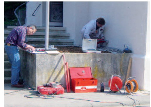
7 Eingehende Kontrolle nach Abschluss der Arbeiten zur Qualitätssicherung. (Fotos: Dr. Kollmann)
